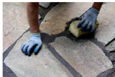
GftK-sauma kovettuu erittäin lujaksi.
