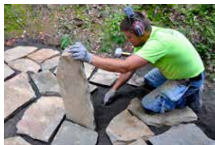
Kiven korkeutta säädetään lisäämällä ja poistamalla kivituhkaa kiven alta.
